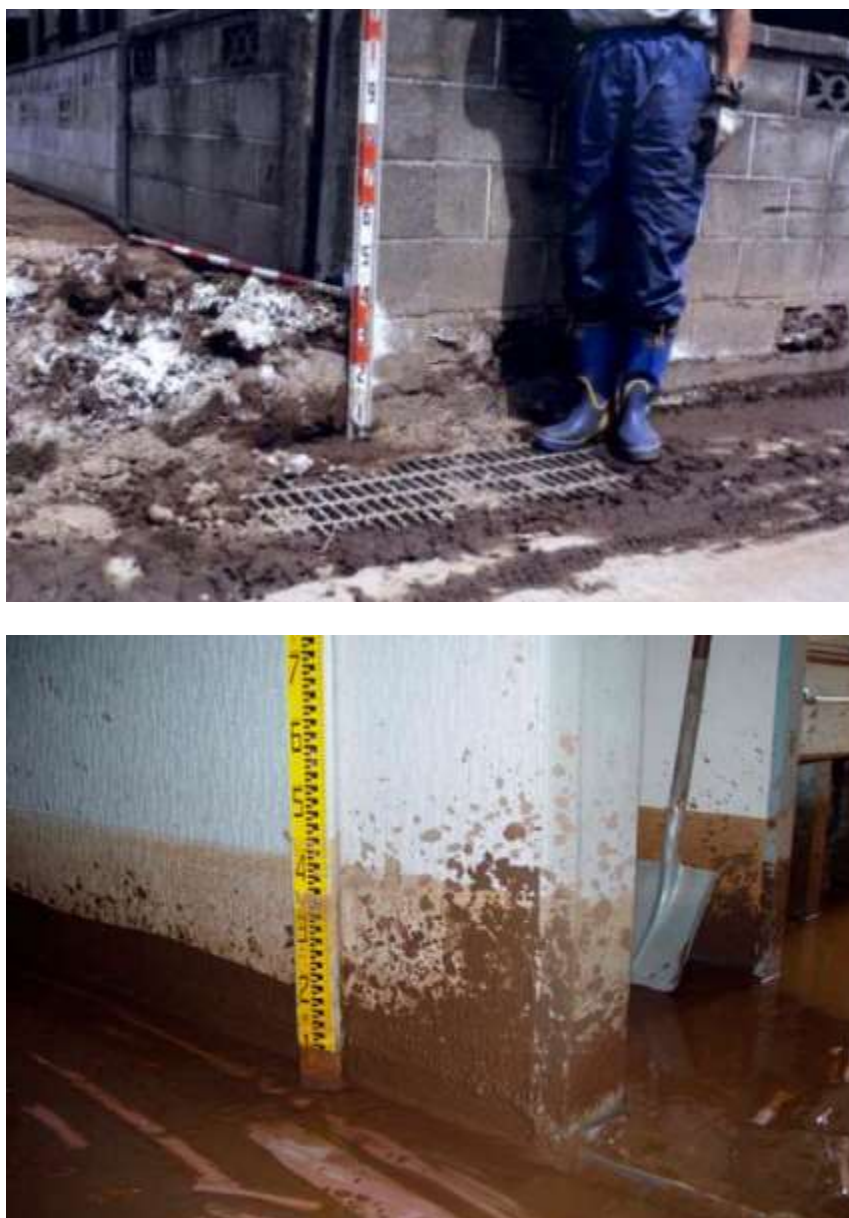
図 2-12-(3)-2 被災状況の記録（上：実際の堆積状況 下：痕跡による測定）
