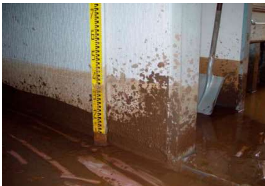
図2-12-(3)-2 被災状況の記録（上：実際の堆積状況 下：痕跡による測定）
