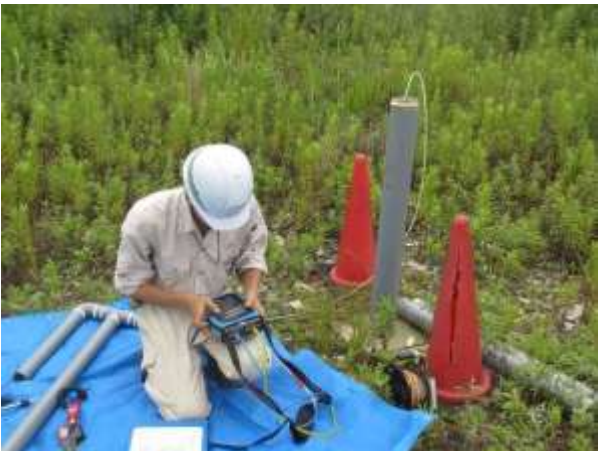
写真2 孔内ガス測定状況の例
