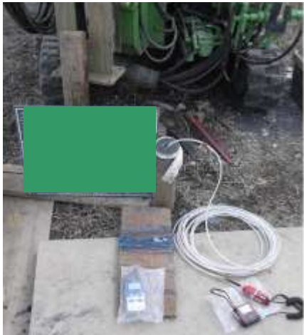
写真 2 孔内ガス測定状況の例
