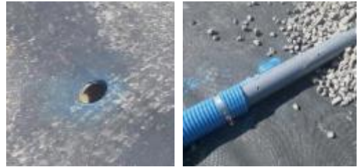
図 6 シート穴、有孔管の状況
