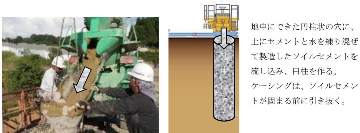
図 3-2-4 ソイルセメントを流し込む状況
