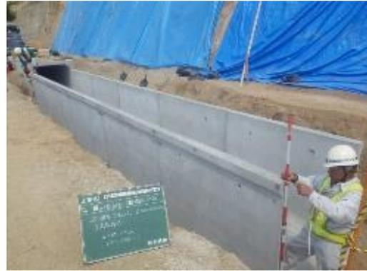
写真 3-3-12 上流域転流工（付替え水路工）（H29.6）
