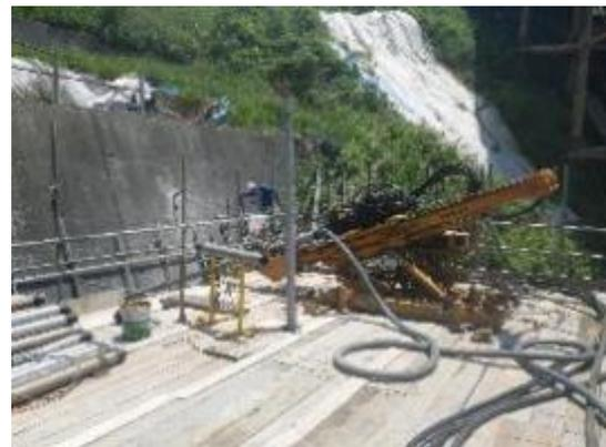
写真 3-3-10 斜面对策工 (アンカー工)
