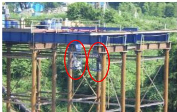
写真 3-3-7 鉛直遮水工のための仮設工（仮栈橋）
