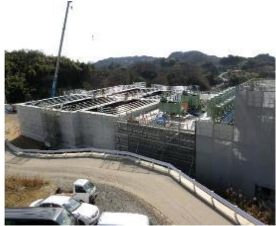
写真 3-3-9 鉛直遮水工・水処理施設工
