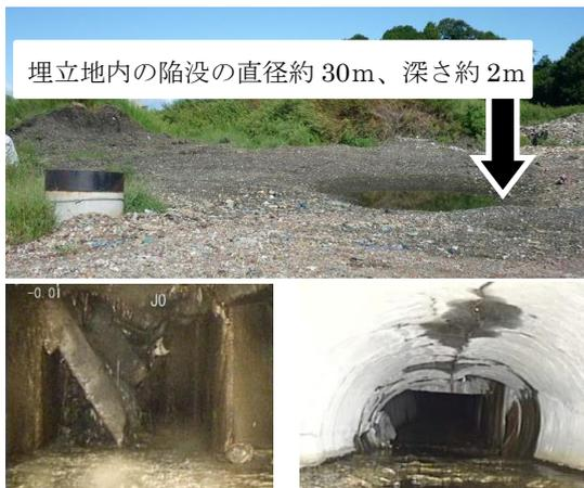
写真 1-2-1 灰濁水が流出した際の処分場
