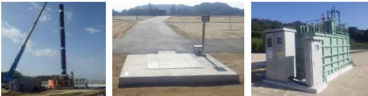
写真 3-2-5 取水設備（保有水揚水井戸）（左：井戸の施工状況、中央：井戸上部、右：集水ピット）
