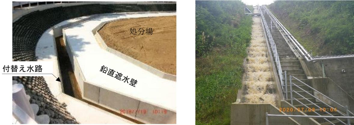
写真 3-2-1 付替え水路（左：開水路、右：斜面部の階段水路）
