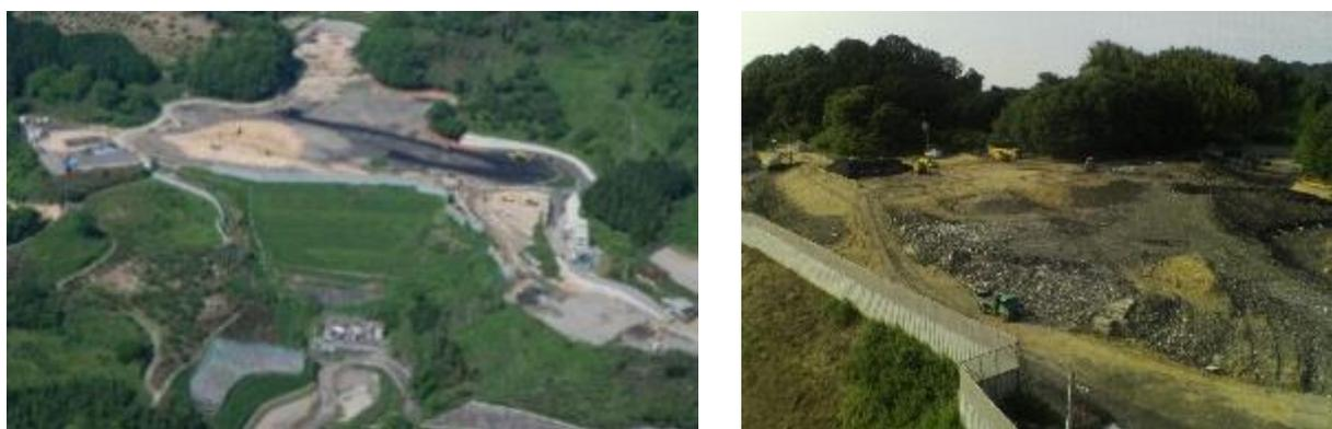
写真 3-3-2 造成工 (左：整地作業の全景 (H28.5)、右：処分場埋立地の整地作業)
