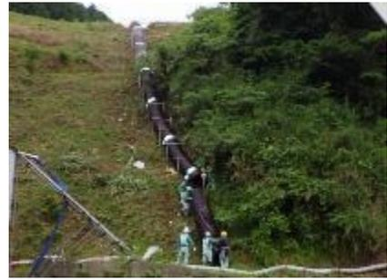
写真 3-3-3 場外への汚水流出防止のための仮設工
