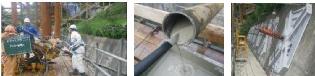
写真 3-2-8 アンカー工（左：アンカー挿入、中央：固定液注入、右：アンカー受圧板）
