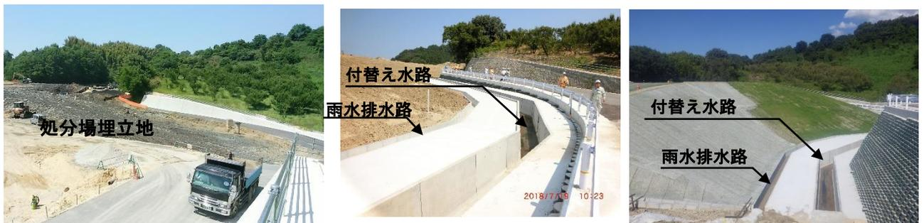
写真 3-2-4 雨水排水路（左：施工前、中：施工状況、右：完成）
