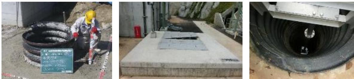
写真 3-2-6 取水設備（地下水揚水井戸）（左：井戸の施工状況、中央：井戸上部、右：井戸内部）
