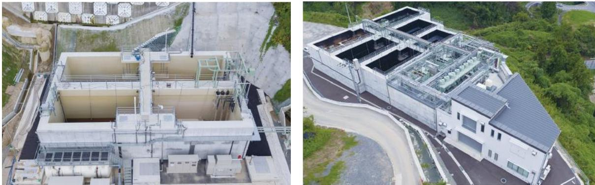
写真 3-2-7 貯留槽（左：第 1 貯留槽、右：第 2 貯留槽（奥）及び水処理施設（手前））
