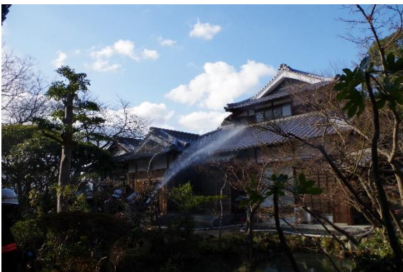
消防隊による放水
