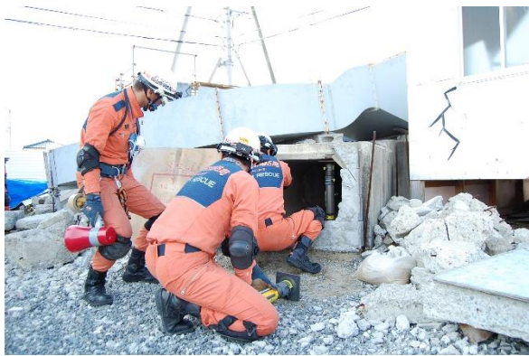
7. ショアリングによる進入口作成状況
