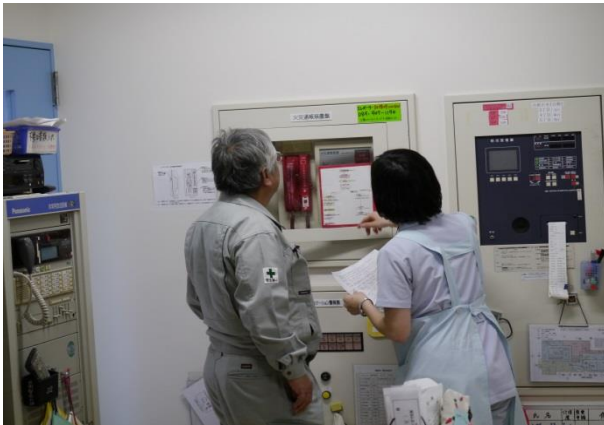
3 119番通報(火災通報装置使用)
