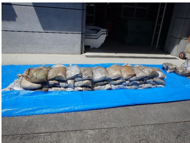
改良積み土のう工法③
