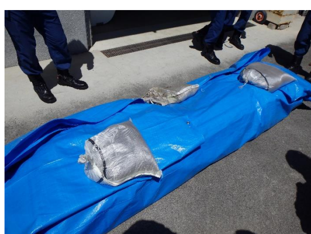
改良積み土のう工 完成
