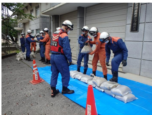
改良積み土のう工法①
