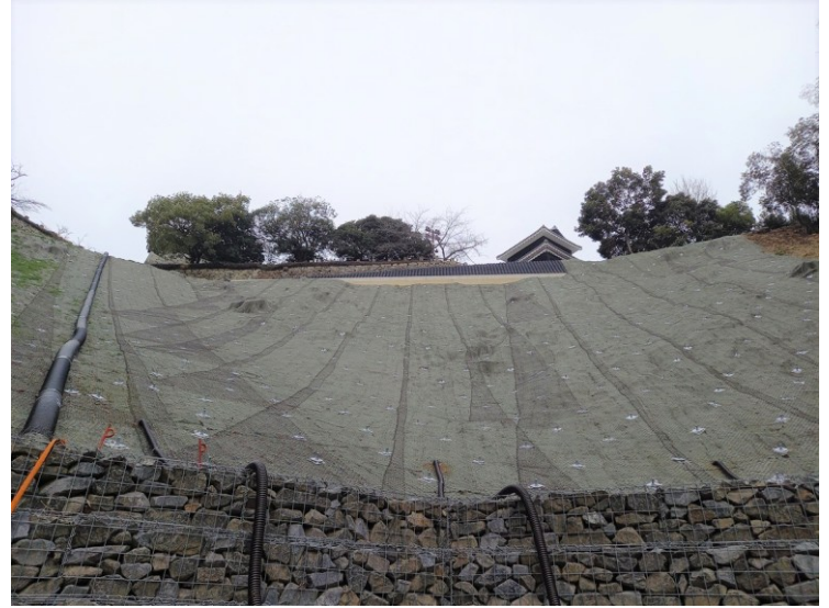
⑤山の中腹部(山腹土留・水路施工完了)
