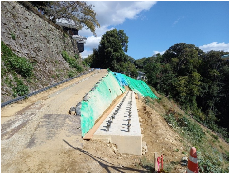
③良門付近から(特殊な杭基礎施工完了)
