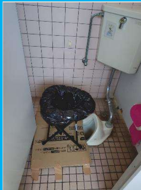
簡易トイレ+携帯トイレ (体育館和式トイレ)
