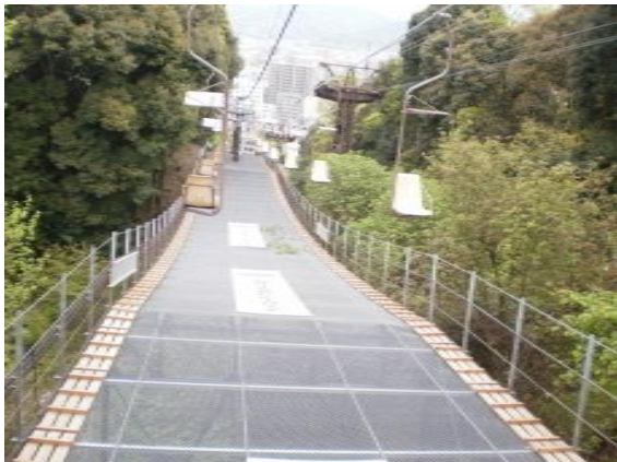
（更新工事を終えたリフト）
