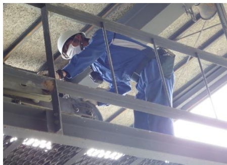
ロープウェイ走行装置の点検
