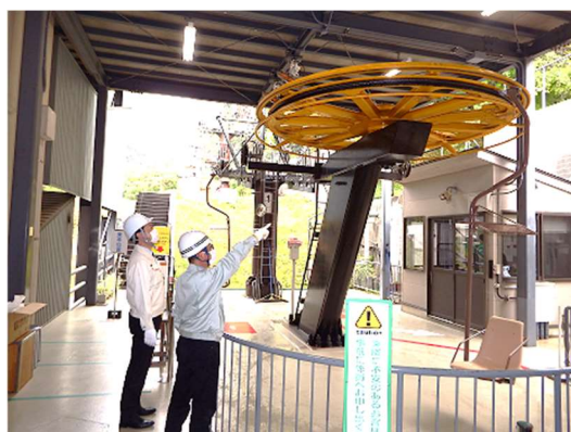
安全統括管理者による設備巡視
