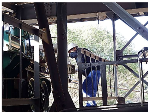
ロープウェイ曳索の点検
