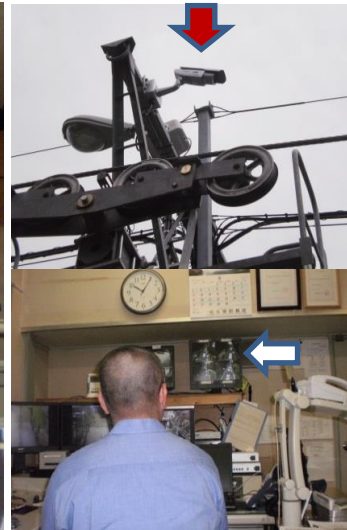
（上）；リフト支柱上に取り付けられたカメラ （下）；運転室に設置されたモニターTV
