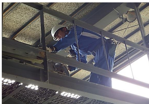
ロープウェイ走行装置の点検
