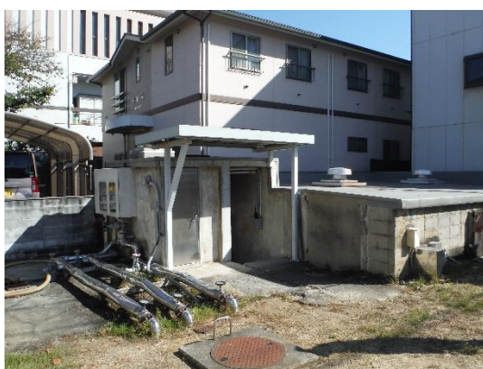
14・15・24号源泉建屋外観
