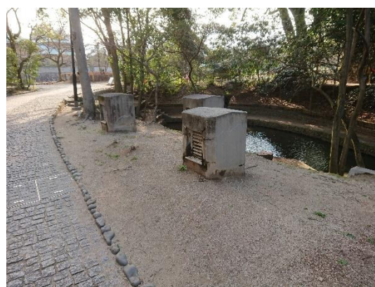
第5分湯場外観（上部）
