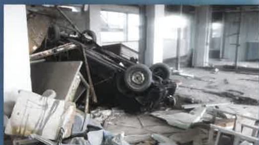
津波で壊滅的な打撃を受けた宮城県立気仙沼向洋高等学校の校舎内。「気仙沼市東日本大震災遺構・伝承館」として整備され、今年3月10日から公開される。同校生徒たちは震災の翌年、愛媛県の招致で坂の上の雲ミュージアムに訪れ、愛媛県立松山北高等学校コーラス部の生徒たちと気仙沼向洋高等学校の校歌を力強く合唱した
