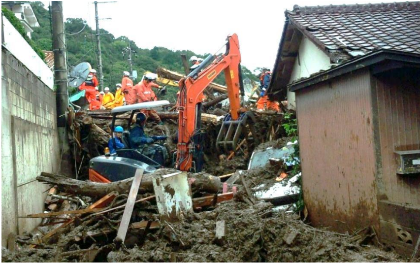
1 土砂による埋没者 救出現場
