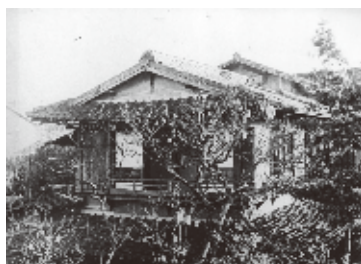
愚陀佛庵2階外観
