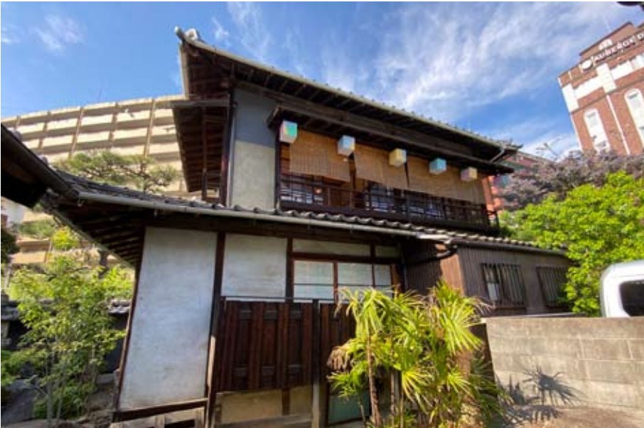
外観（南西から）
