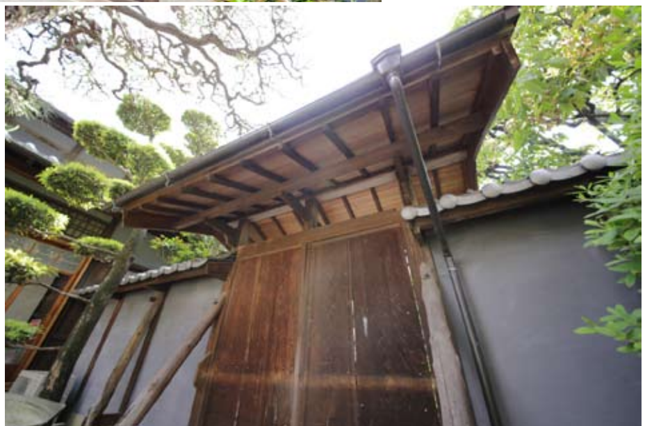
背面見上げ（北東から）
