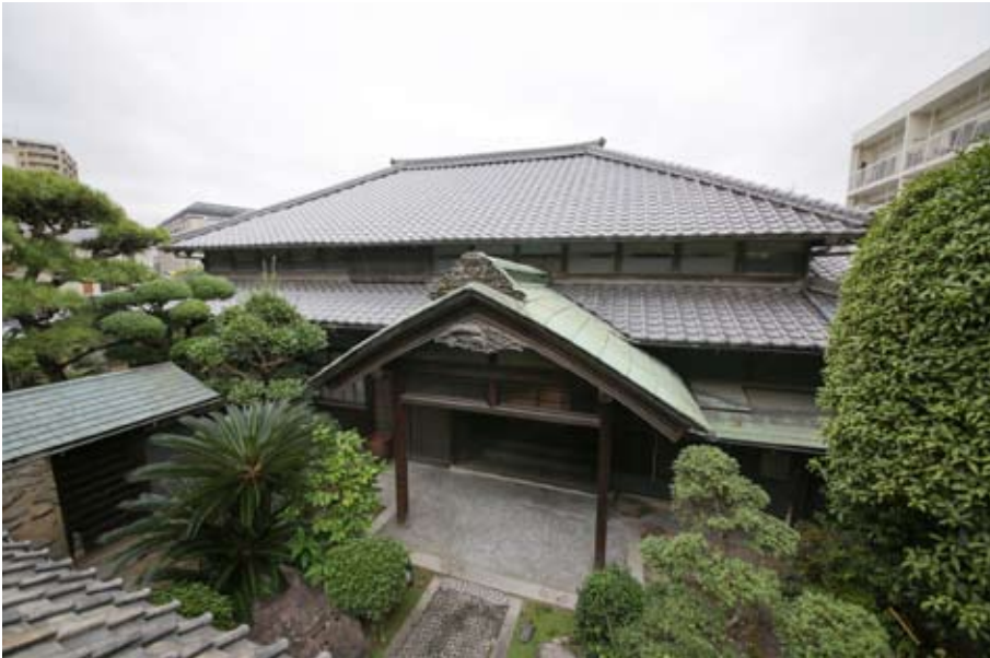
外観（北西から）
