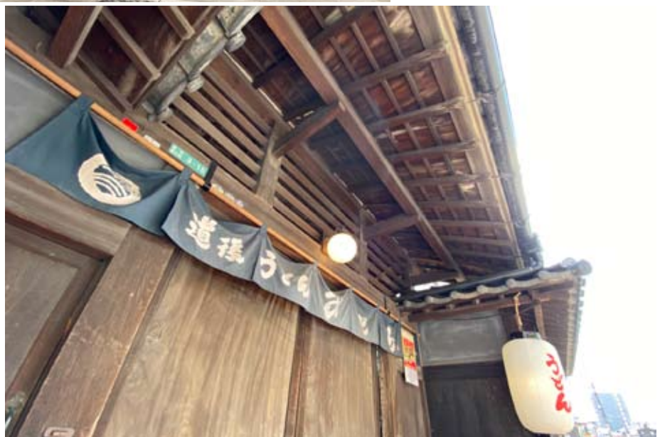
正面見上げ（北東から）
