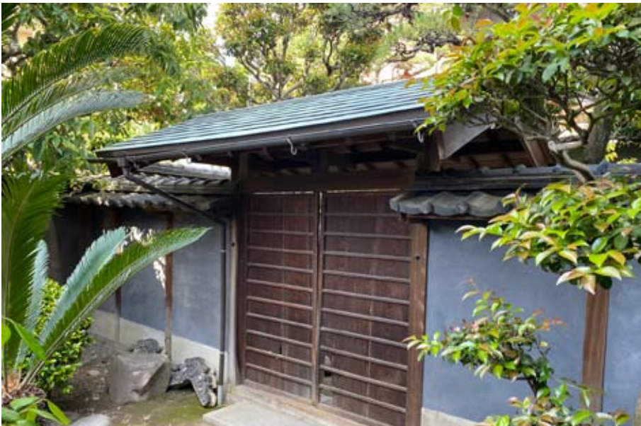
外観（南西から）
