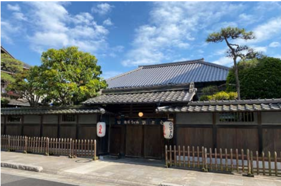
外観（北西から）
