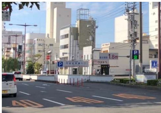
【中之川地下駐車場（入口付近）】
