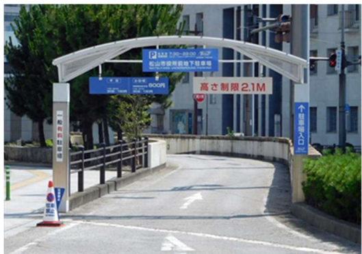
【市役所前地下駐車場（入口付近）】
