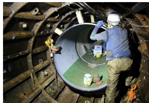
継続的な取組：基幹管路の耐震化 (シールド工事の様子)
