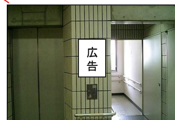
⑥1階エレベーター扉横掲出場所
