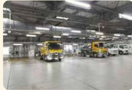
受入室 臭気を外部に漏らさないように十分な対策を施しています。
