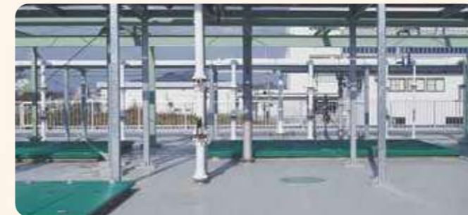
硝化槽・脱窒素槽 硝化槽では、し尿・浄化槽汚泥に含まれるアンモニアを硝化菌が硝酸に変えます。脱窒素槽では、脱窒素菌がし尿中の有機物を栄養源にして、硝化槽から循環してくる硝酸を窒素ガスに変えます。
