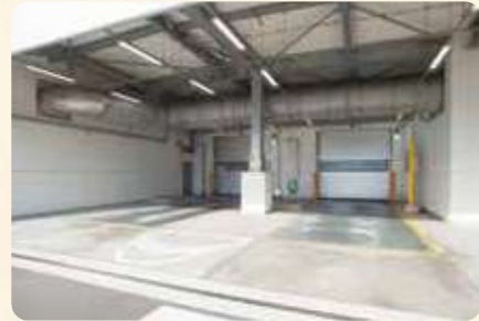
トラックスケール し尿・浄化槽汚泥の重さを計ります。
