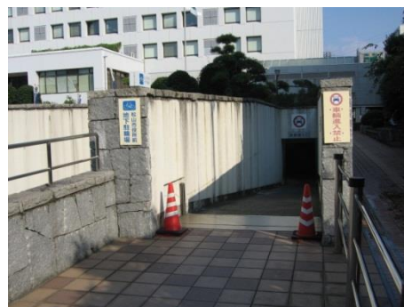
(松山市役所前地下駐輪場)
