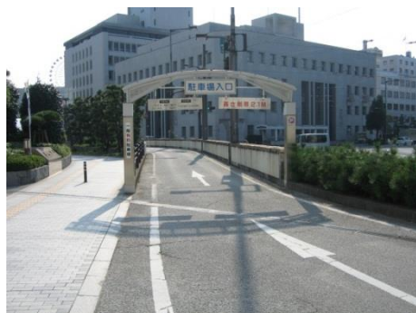
(松山市役所前地下駐車場)
