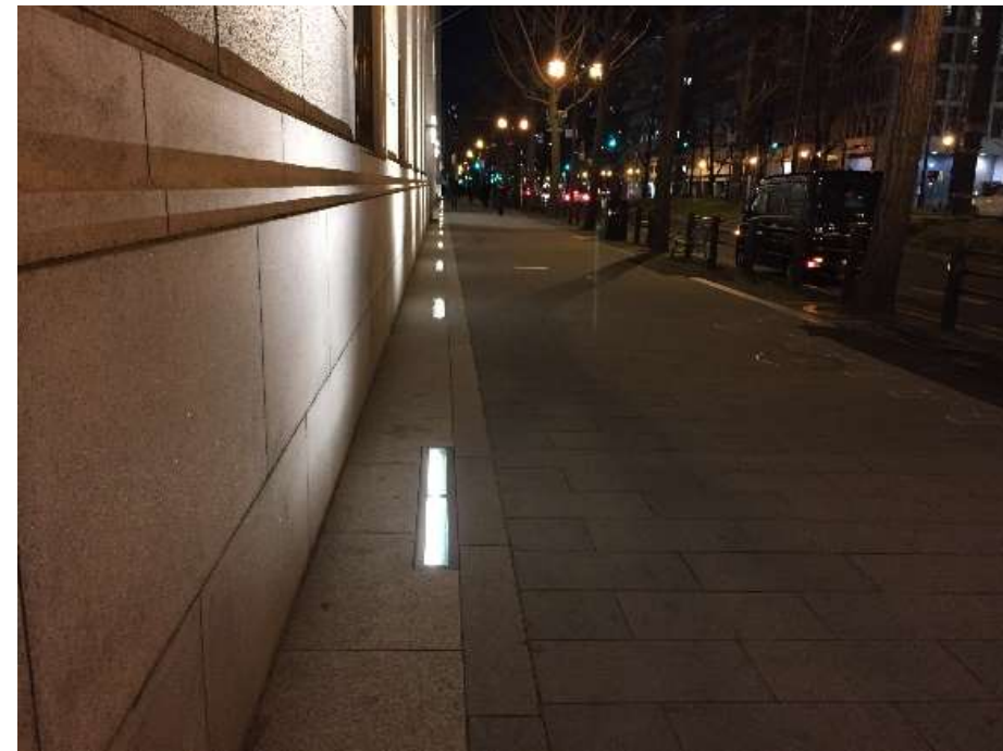
民間敷地と歩道との境界部分に照明を設置し、街灯と合わせて歩道の明るさを確保
