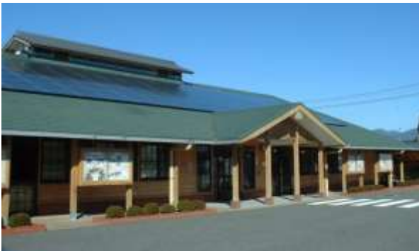
太陽光パネルを設置した施設
