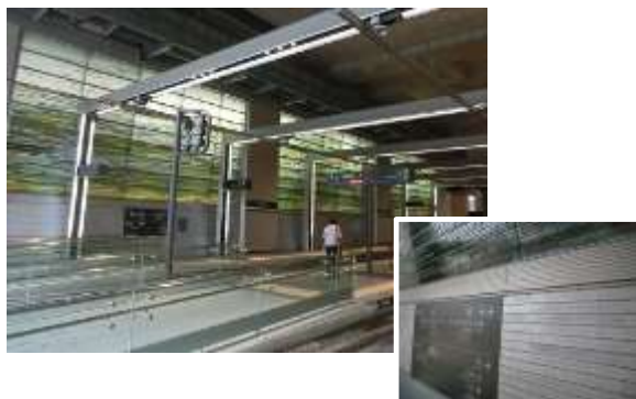
壁面を工芸ガラスで装飾した トランジット・ライティング・ウォールと、 寄付者のメッセージと名前入アルミパネル
