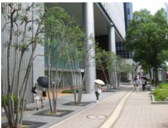
低層部のセットバック空間と植栽（神戸市）
