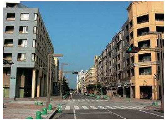
図 ガイドラインで誘導された沿道型住宅（千葉市）
