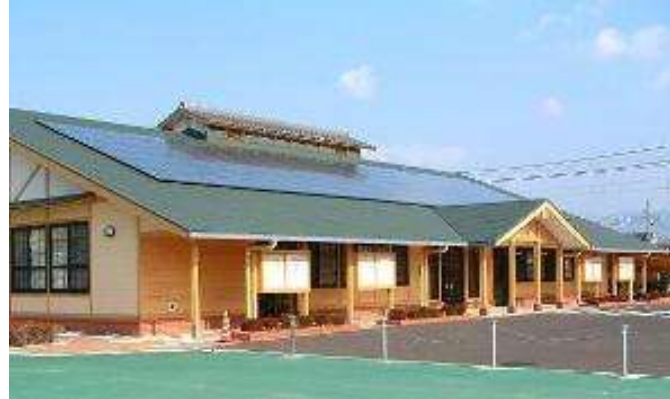
太陽光パネルを設置した施設
