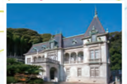
国の重要文化財に指定されている純フランス風の洋館・萬翠荘
