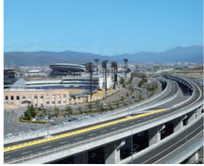
松山外環状道路整備
