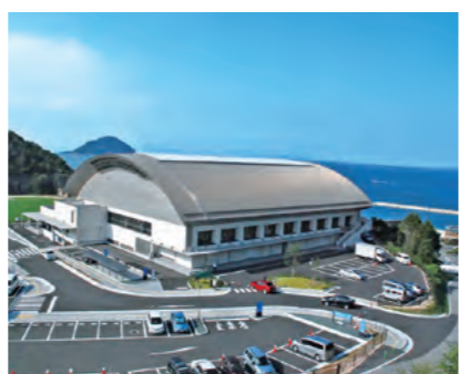
北条スポーツセンター整備完了(平成23年)
