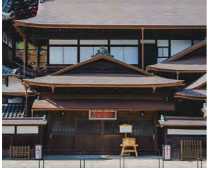
道後温泉本館保存修理工事
