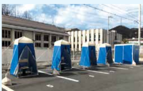
災害用マンホールトイレ
