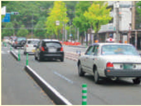
片側1車線化した車道
