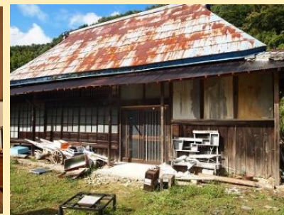
改修中の古民家
