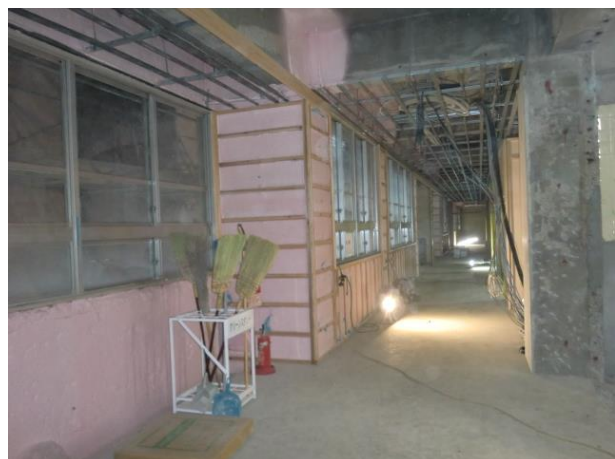
廊下外壁面断熱材吹付
