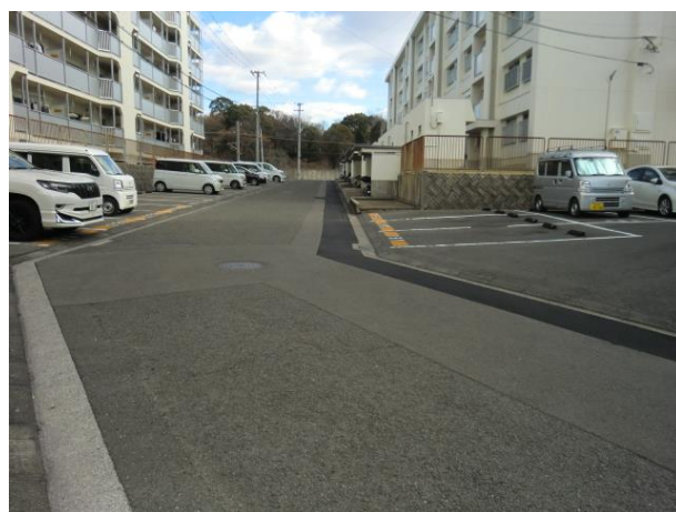
住棟給水配管更新後仮舗装
