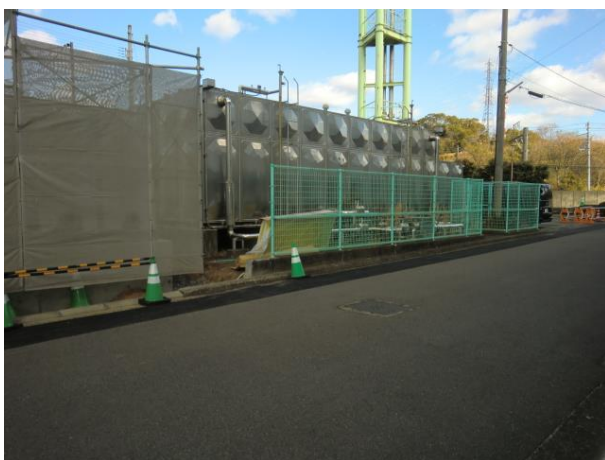
新旧受水槽外観
