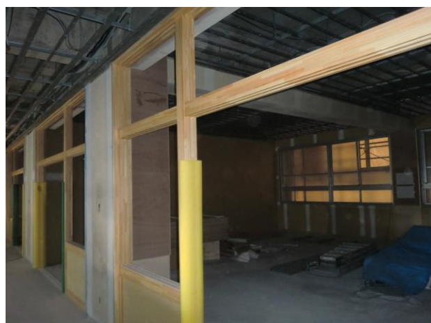
教室廊下間 間仕切り壁・木製建具
