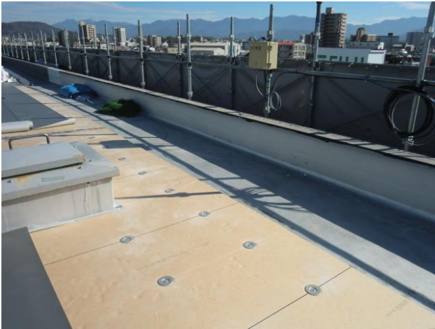
屋上防水改修 シート防水固定ディスク
