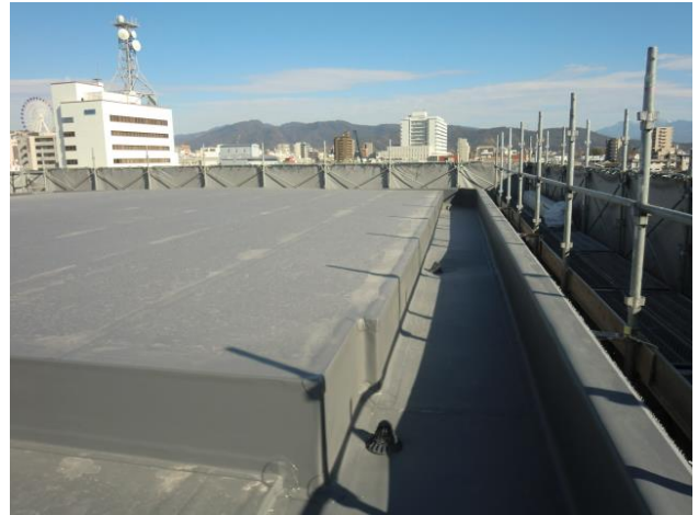
屋上防水改修 シート防水施工状況
