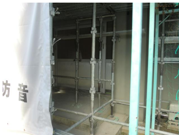
外部足場 防音シート 外壁改修下地
