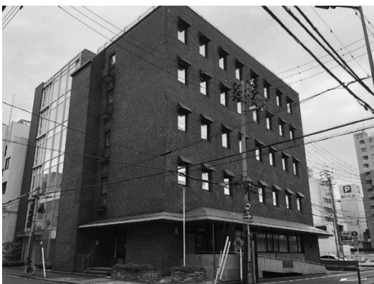
愛媛県松山市二番町／竣工 2004 年 3 月
