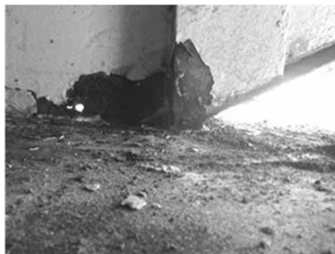
バスターミナル東横断歩道橋 支承付近の階段部主桁で腐食
