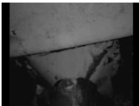
(新玉小学校西横断歩道橋 防鳥パネル内床板腐食)
