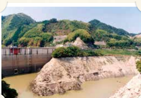
ダムの水位が下がった取水塔付近
