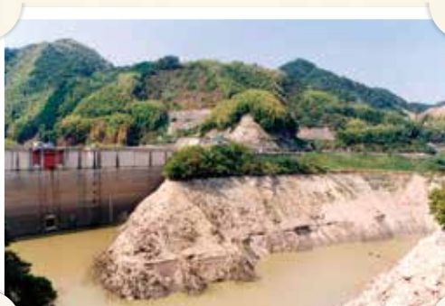
ダムの水位が下がった取水塔付近
