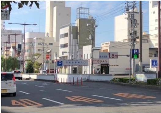
【中之川地下駐車場（入口付近）】
