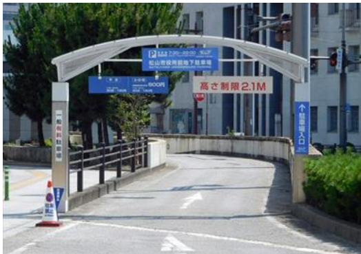
【市役所前地下駐車場（入口付近）】
