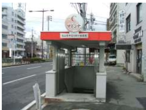
中之川地下駐車場(現況写真)
