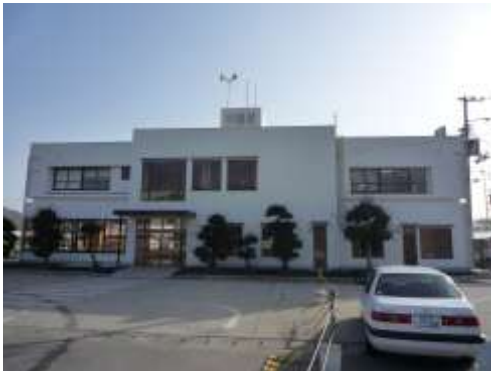
<中島港待合所外観>
