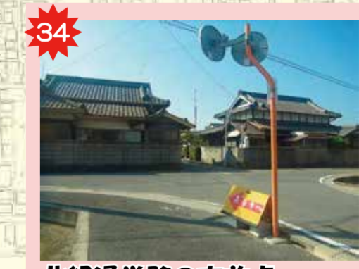
34 北組通学路の交差点 ミラーはあるが、見づらい場所があり、注意が必要。スピードを出して通る車も多く、事故も多い。
