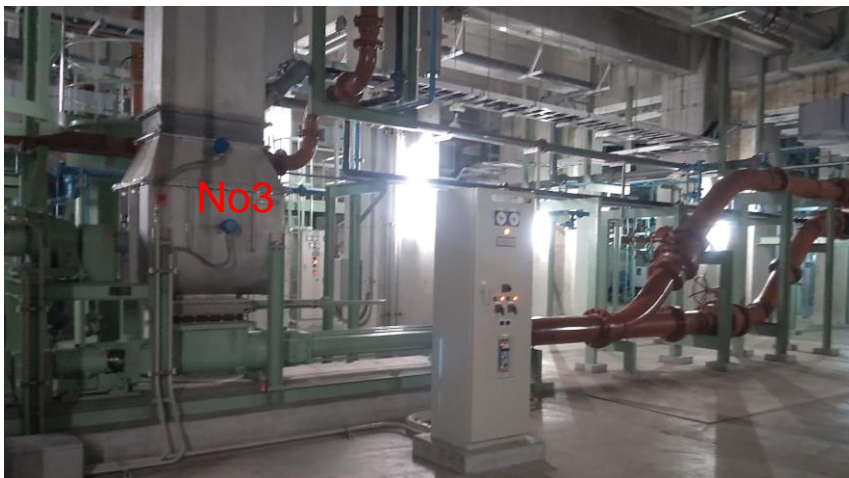
写真（ケーキ圧送ポンプ）
