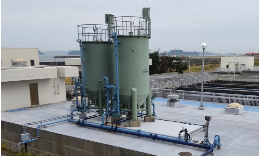
(2)写真 (砂ろ過上部)
