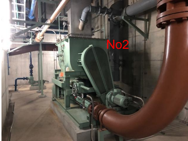
写真（ケーキ圧送ポンプ）
