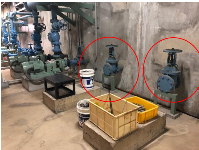
(2)写真 (砂ろ過水取合点 管廊内)
