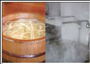
滅菌した地下水ですべて賄っている店もあれば、地下水と上水道を使い分けている店もある。写真右の2つのじゃ口は上水道と地下水の使い分けをしている店のもの。
