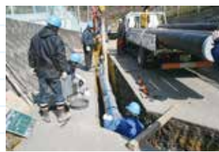
耐震管への取替工事
